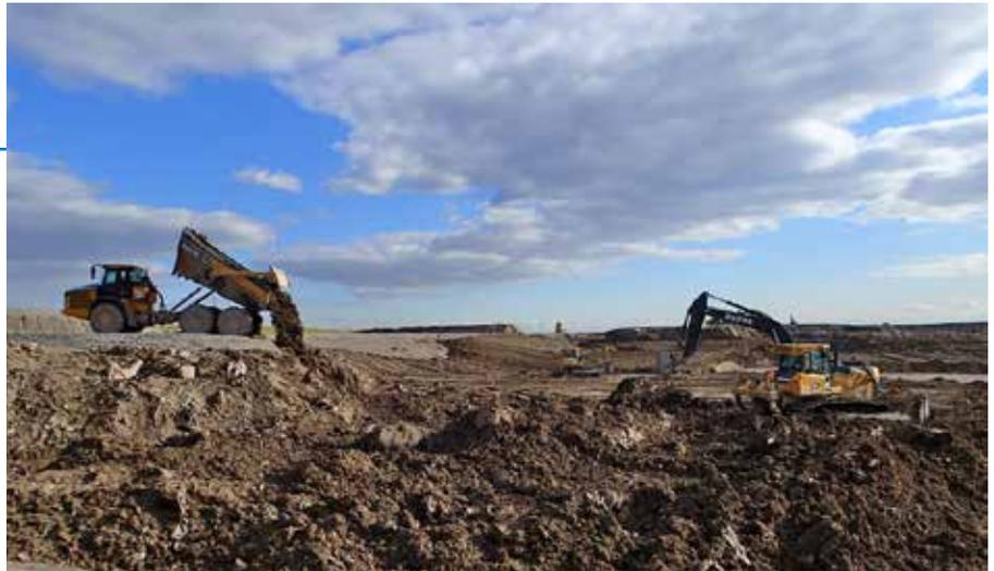
**Pour donner sa forme de drumlin au monticule artificiel, les déchets qui y sont placés (provenant de l'ancien site, sur la rive du lac Ontario) sont d'abord compactés.**
