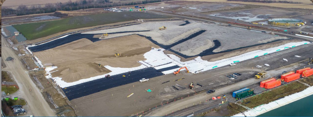
Progression de l'installation des matériaux de couverture
