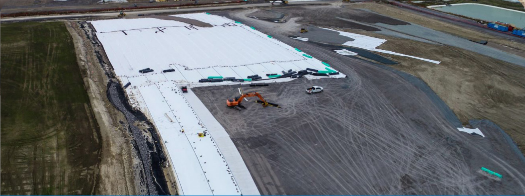
Installation des matériaux de recouvrement provisoire dans la cellule 2
