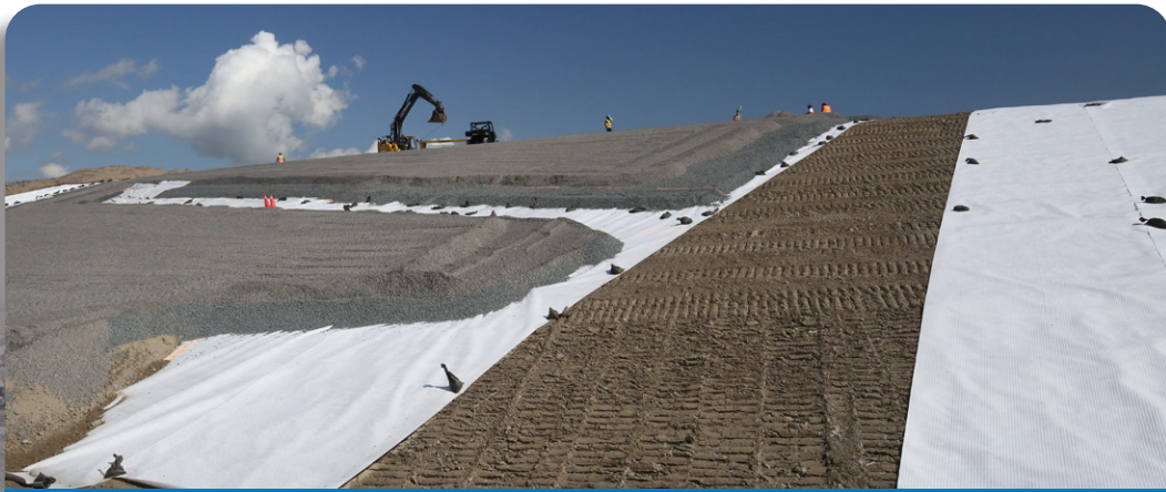
Mise en place des matériaux du revêtement
