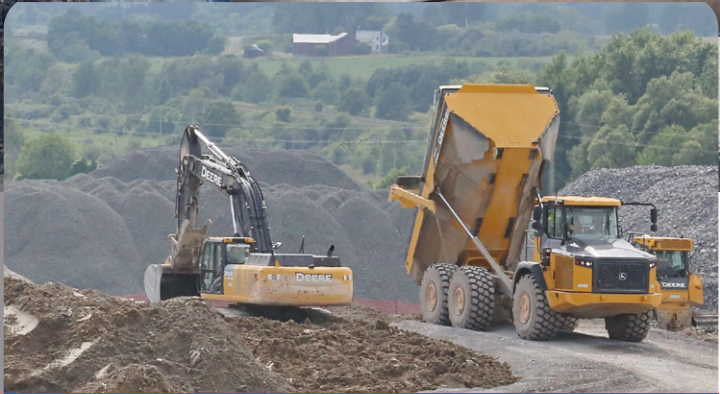
Mise en place des déchets
