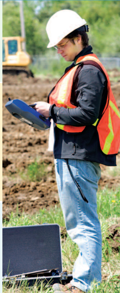
Mesure par moniteurs de poussière portatifs sur les sites d'excavation pour obtenir des résultats en temps réel
