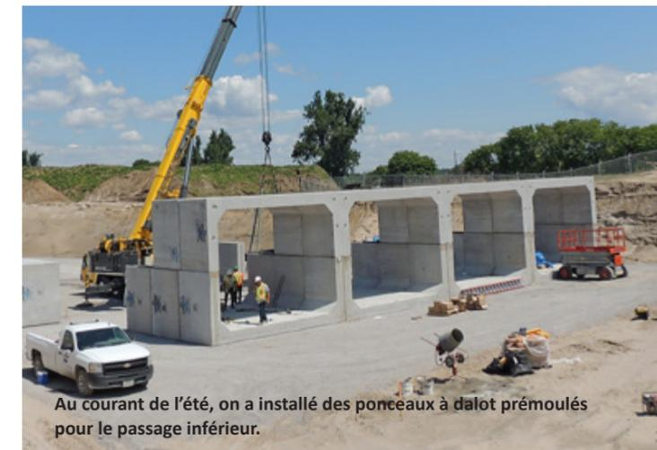
Au courant de l'été, on a installé des ponceaux à dalot pré-moulés pour le passage inférieur.
