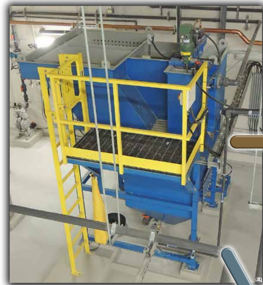
Réservoir d'épaississement de la boue
