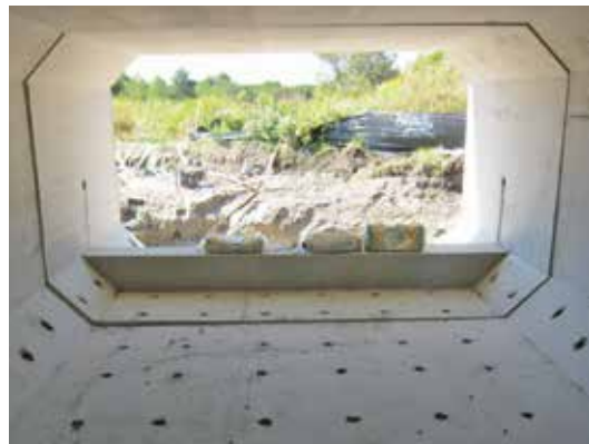
Vue intérieure du ponceau installé
