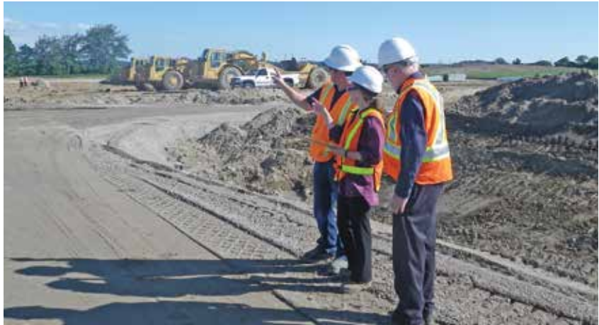
Le chemin Elliott en construction
