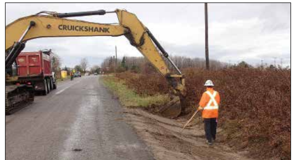
Travaux d'entretien des fossés le long du chemin Concession 1
