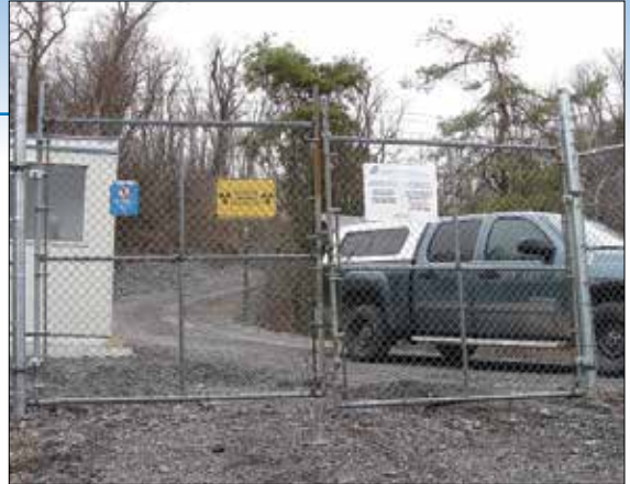
La nouvelle signalisation est l'une des multiples nouvelles mesures de sécurité prises à l'installation de gestion des déchets de Port Granby
