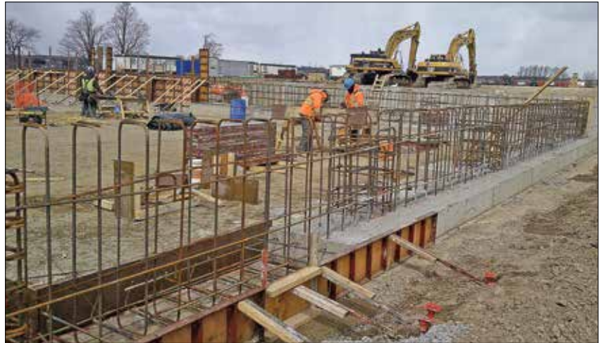
Construction du mur de fondation de la nouvelle usine de traitement des eaux usées
