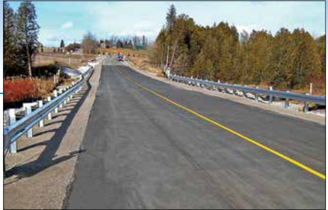
Elliott Road après les travaux de réfection
