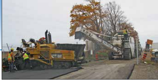
Pavage du chemin Elliott à l'installation du projet de Port Granby
