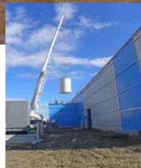
Installation du réservoir d'épaissement
