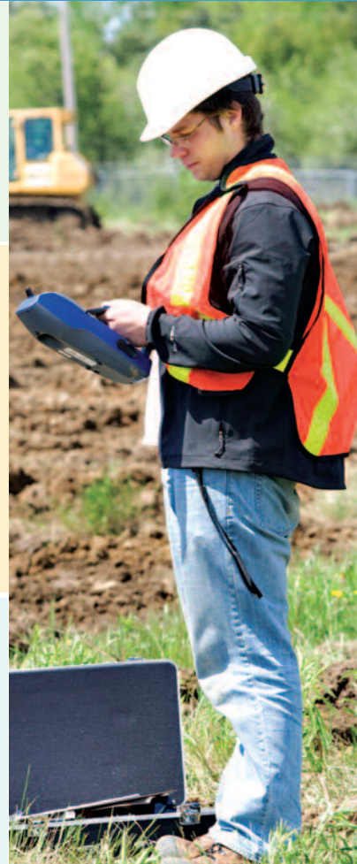
Mesure par moniteurs de poussière portatifs sur les sites d'excavation pour obtenir des résultats en temps réel
