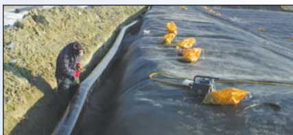
Construction du revêtement de base
