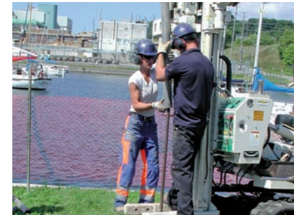
Vérification des murs du port et des sédiments
