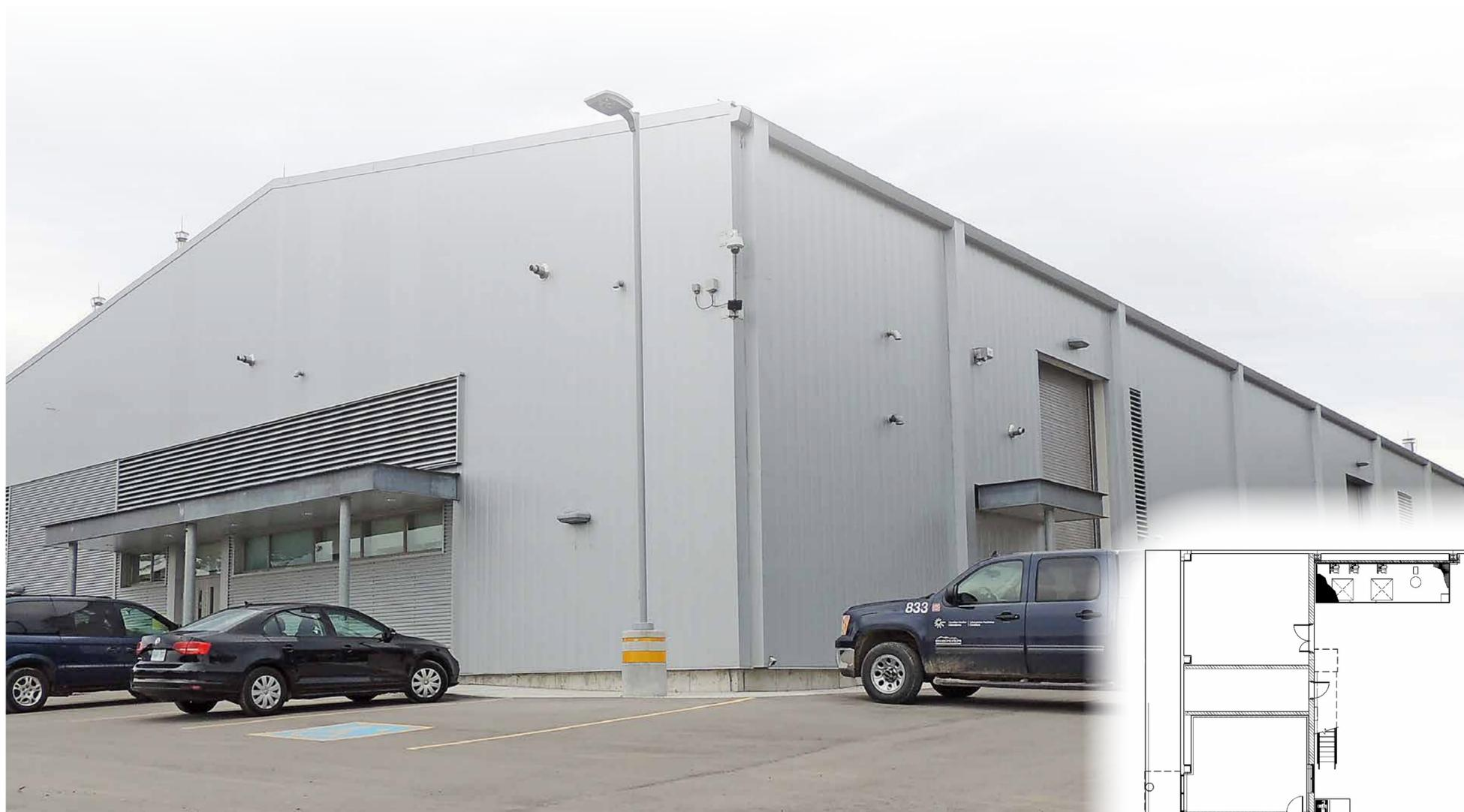
L'usine de traitement des eaux usées permettra de traiter les eaux de surface et les eaux souterraines provenant de l'installation de gestion à long terme des déchets pendant la mise en place des déchets dans le monticule artificiel en surface, ainsi que l'eau contaminée s'écoulant du monticule une fois que le monticule aura été recouvert et fermé. Le procédé de traitement des eaux usées se fera en deux étapes : précipitation chimique et clarification (étape 1), et osmose inverse (étape 2).
