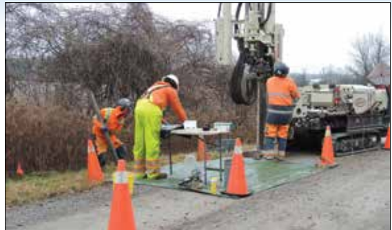
Forage de trous le long de la canalisation abandonnée
