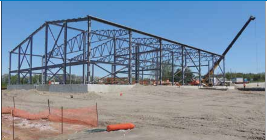
La structure en acier de la nouvelle usine de traitement des eaux usées
