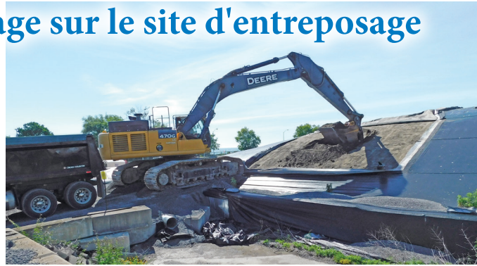
Excavation des déchets historiques entreposés temporairement sous une bâche sur le quai central
