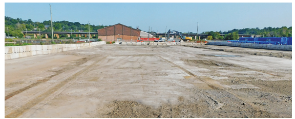
Le quai central après le retrait des déchets
