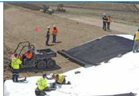
Installation de PEHD en Cellule 1
