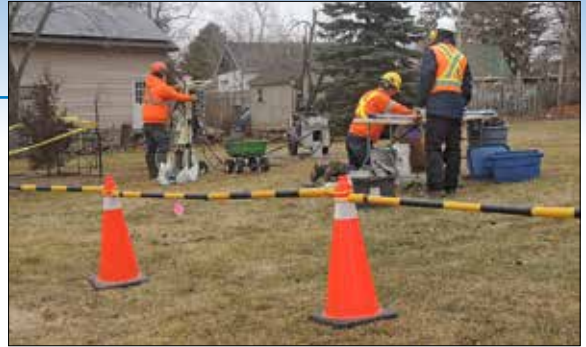
Forage de trous / échantillonnage du sol
