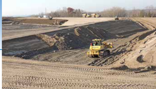
Automne 2016 : travaux d'excavation en vue de construire la cellule 1
