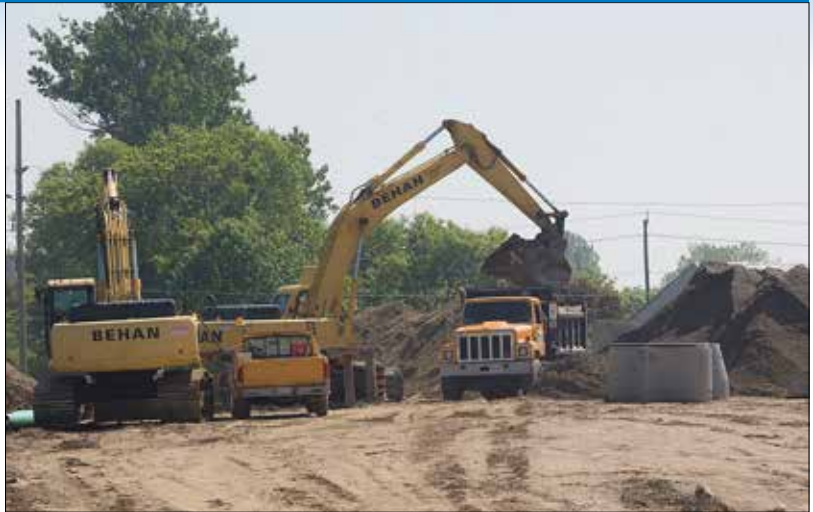
Construction de la route d'accès du projet de Port Hope
