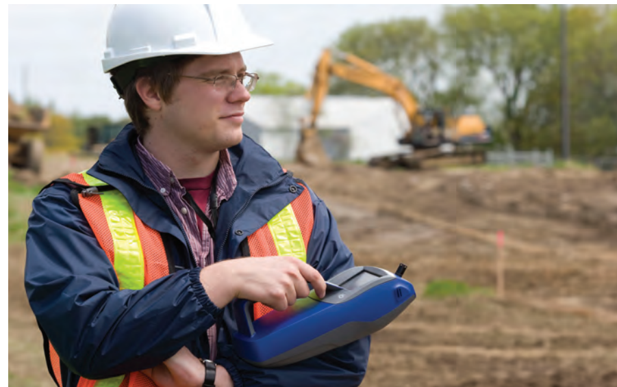
Des relevés de la qualité de l'air sont pris et transmis chaque jour de divers endroits du chantier de construction
