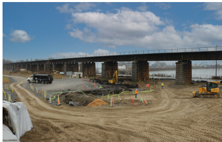
Assainissement des viaducs CN-CP en cours
