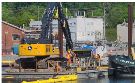
Assainissement du port de Port Hope en cours
