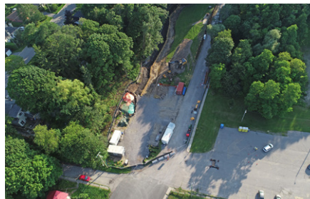
Restauration du site du ravin de la rue Strachan
